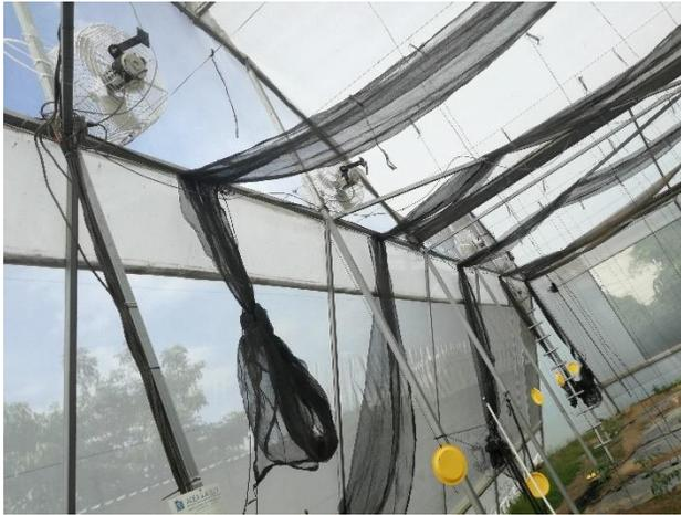
**Figura 9** Ventiladores montados como inyector-extractor
